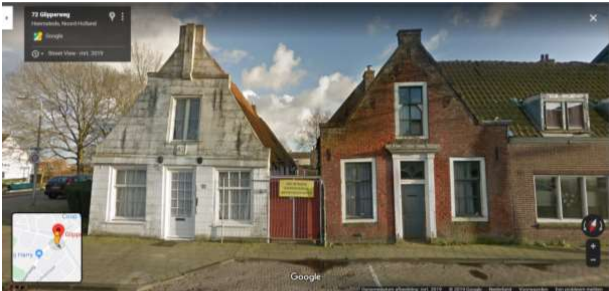
Figuur 3: Indruk van de panden aan de Glipperweg 72 te Heemstede vóór de sloop, gezien richting O vanaf de straat. Het huis links op de hoek dateert uit 1660 (bron: BAG-viewer). Bron foto: Google streetview, maart 2019. Zie ook foto op pag. 2 voor huidige situatie.
