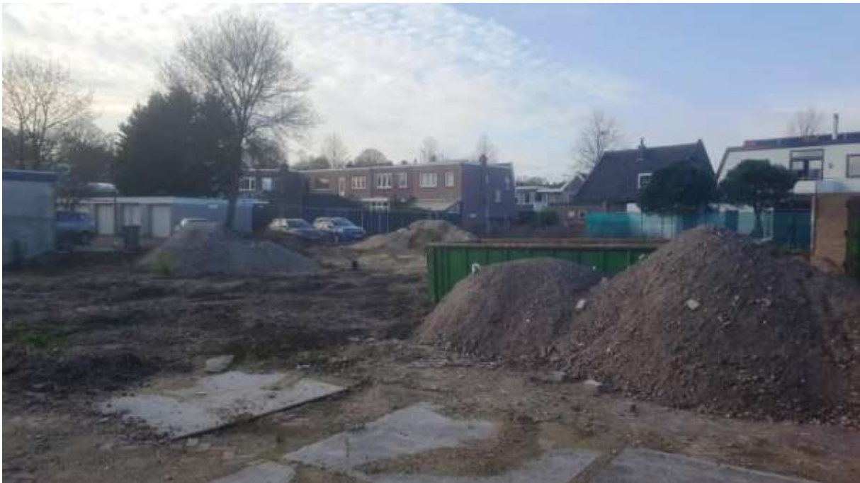
Figuur 11: Indruk van het zuidwestelijk deel van het terrein, gezien vanaf het midden van het terrein: veel zand, enkele hopen grond, container, stelconplaten en vrijwel geen begroeiing.
