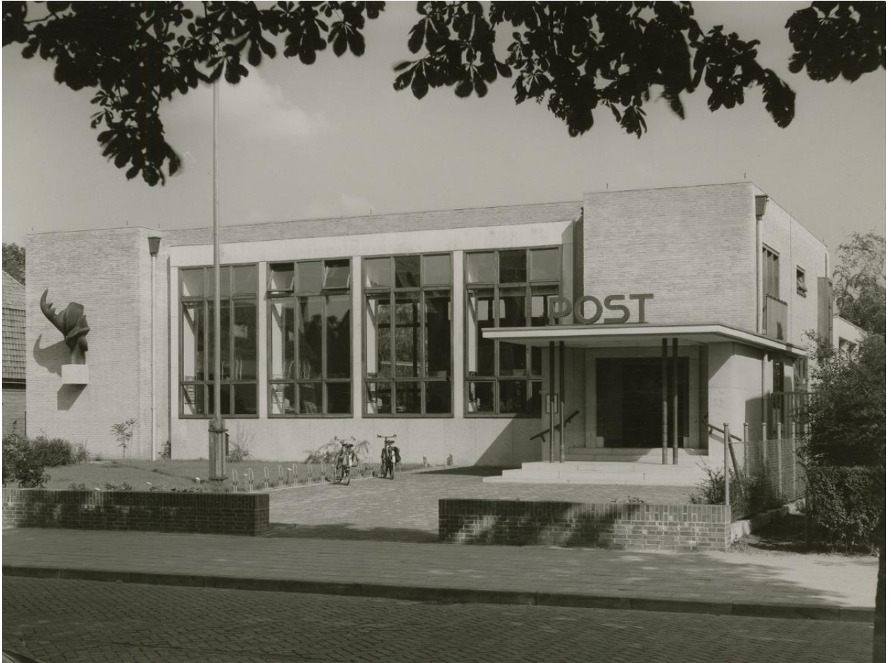
Het postkantoor aan de Binnenweg. Foto kort na de bouw in 1959.
