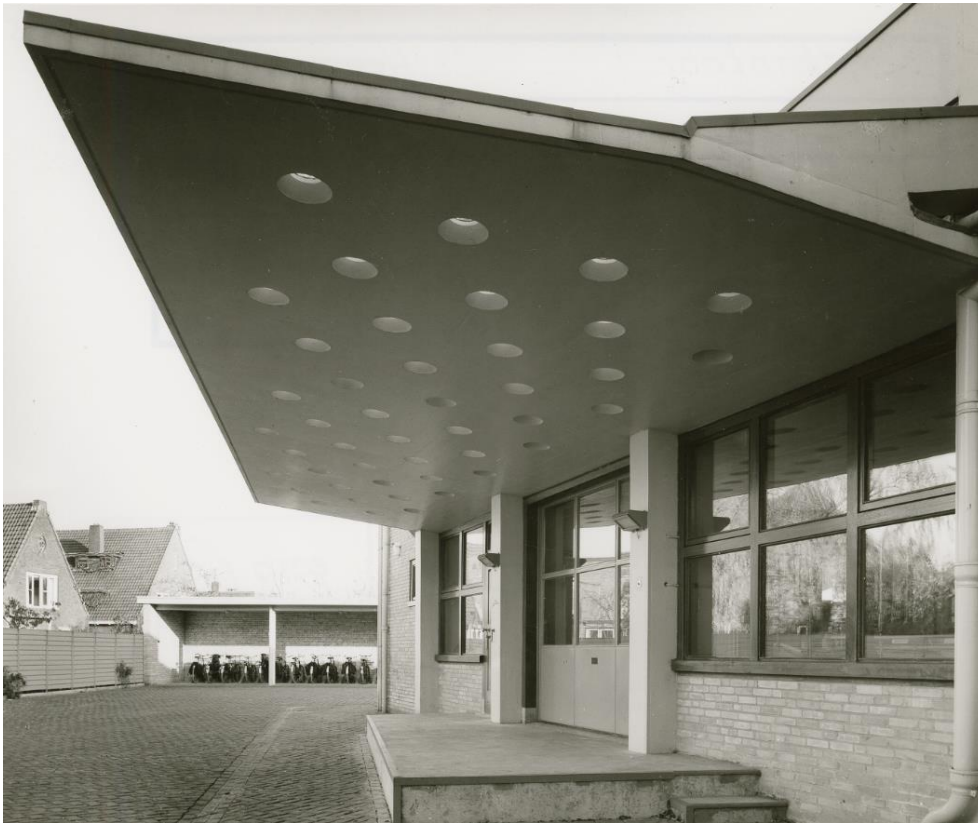
De betonnen luifel boven de expeditie. Foto kort na de bouw in 1959.
