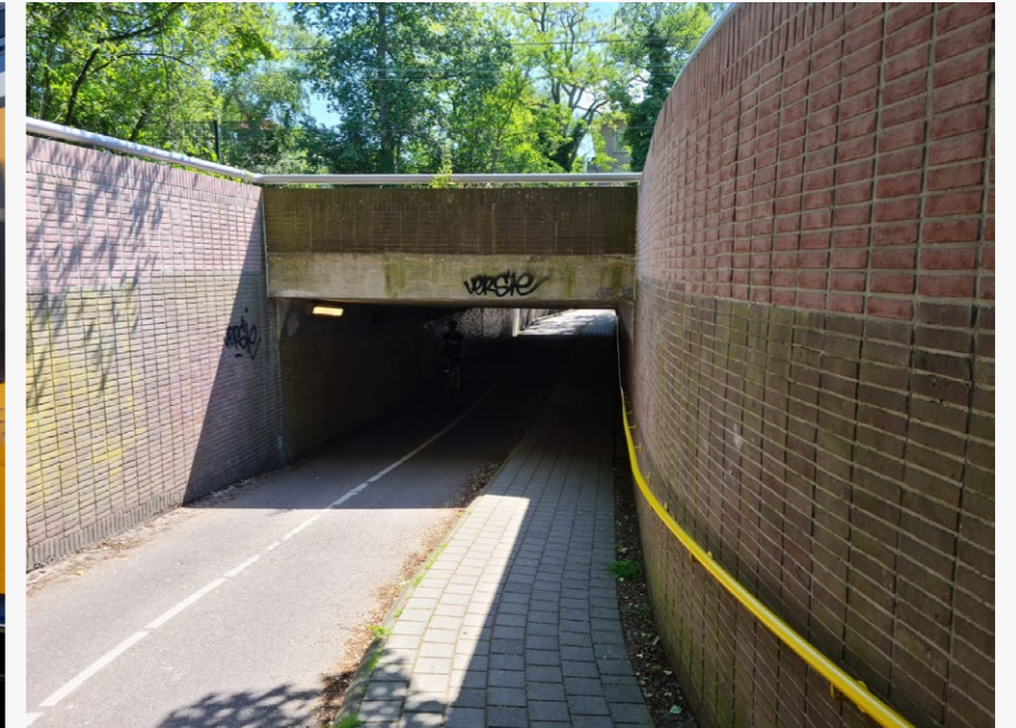
Onderdoorgang bij station Bloemendaal
