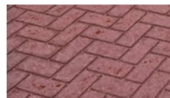
Figuur 14 Voorbeeld asfalt met streetprint
