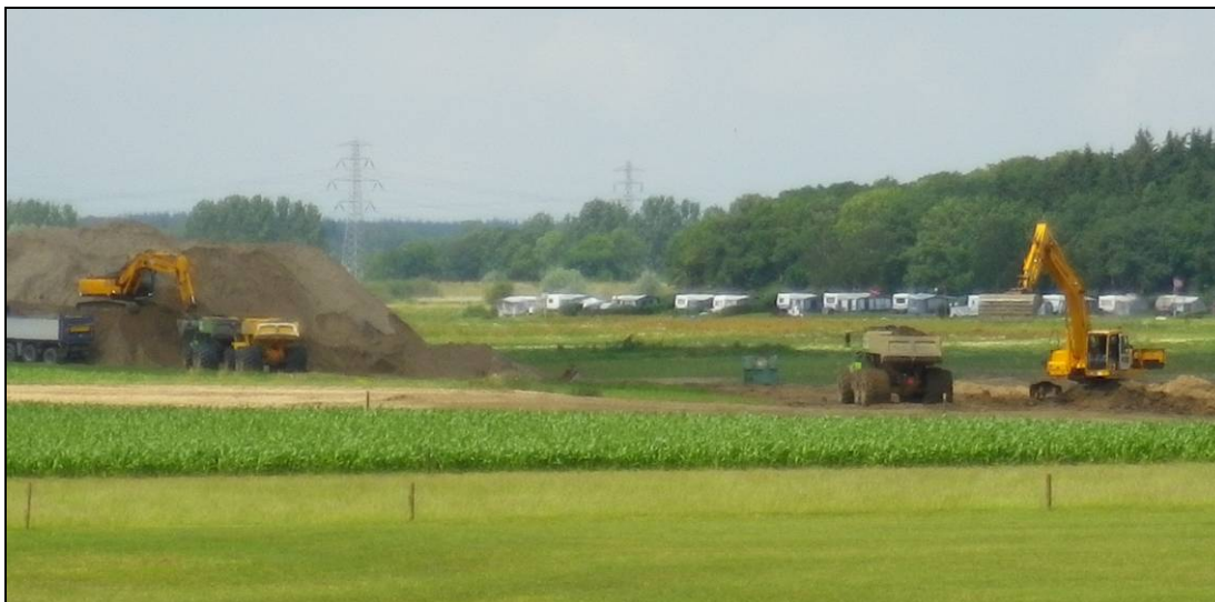
Figuur 5.6.1: Graafwerkzaamheden in de Oenerdijkerwaarden
