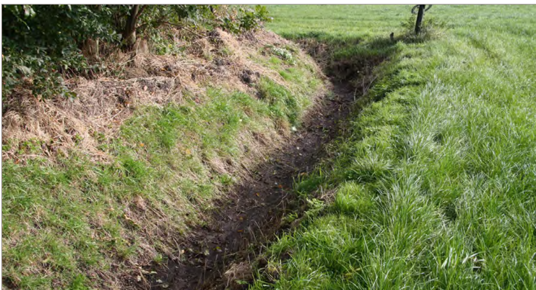
Afbeelding 11. Foto: Greppel/ afwateringssloot langs noordgrens eigendom
