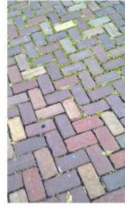
karrespoor gebruikte klinkers
