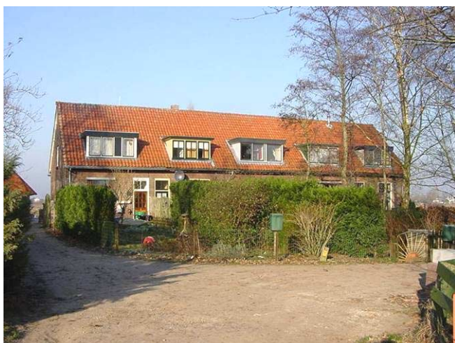
Foto 11. Rijtje voormalige arbeiderswoningen in Fortmond
