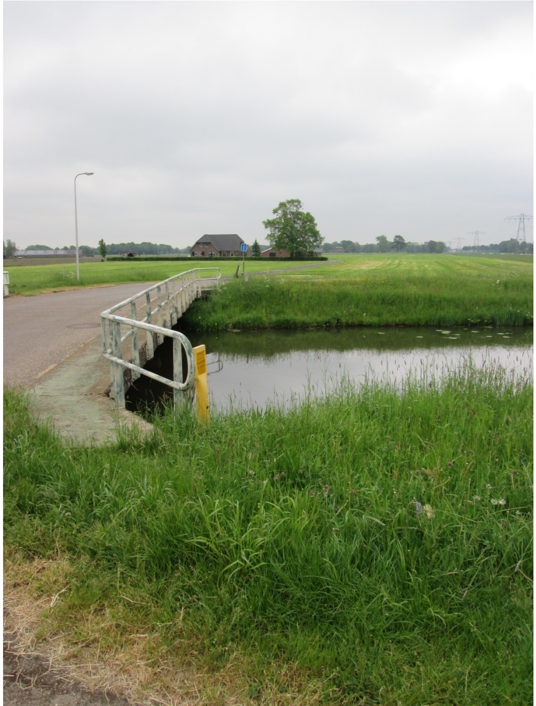
Foto 4. Soestwetering, deze watergang wordt door middel van boring doorkruist. In het water vinden geen werkzaamheden plaats.
