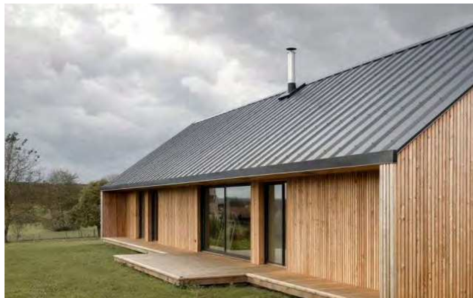
Afbeelding 29. Sfeerbeeld van materiaalgebruik bijgebouwen: blank hout, vertikaal toegepast, met donkere dakbedekking.
