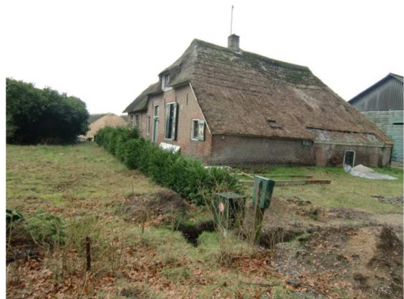
Bestaande boerderij, slopen en nieuwbouw
