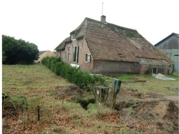
Bestaande boerderij, slopen en nieuwbouw
