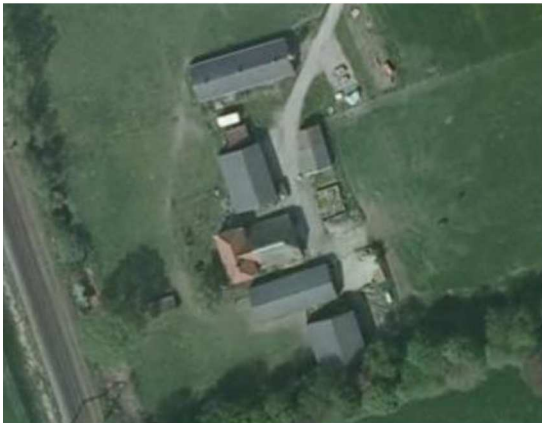
Overzicht erf aan Zandweteringspad 6 Olst
