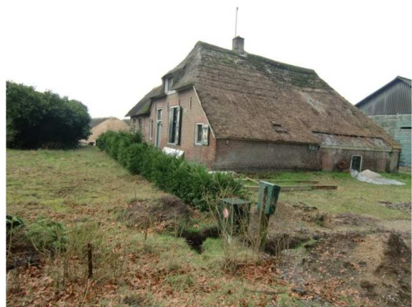
Bestaande boerderij, slopen en nieuwbouw
