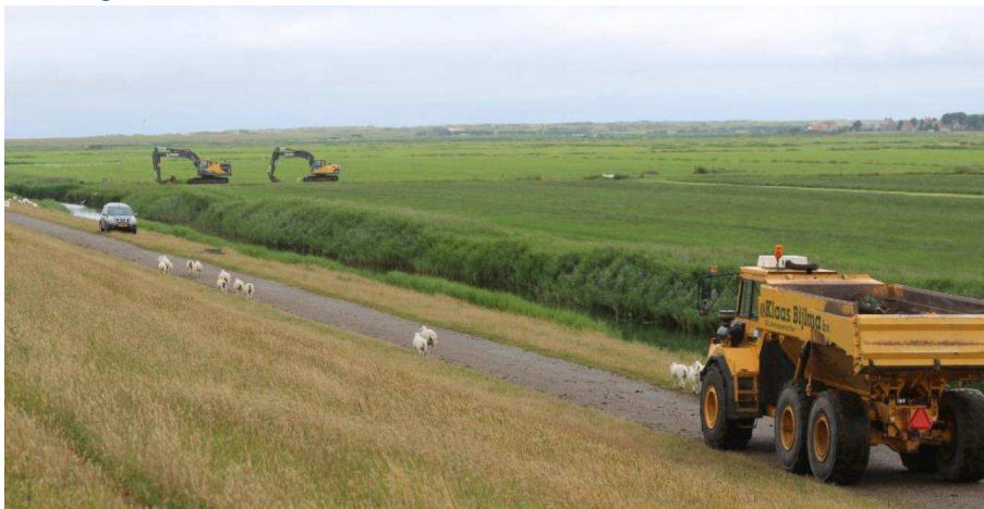
Figuur 4-3. Grondtransport door zwaar materieel.
