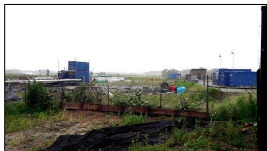
Figuur 2.3: Asfaltsanering noordelijk van de molen
