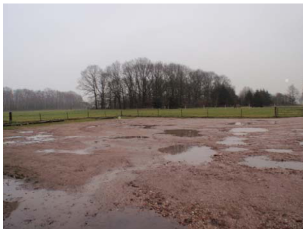
Afbeelding 4: Gebroken puinverharding
