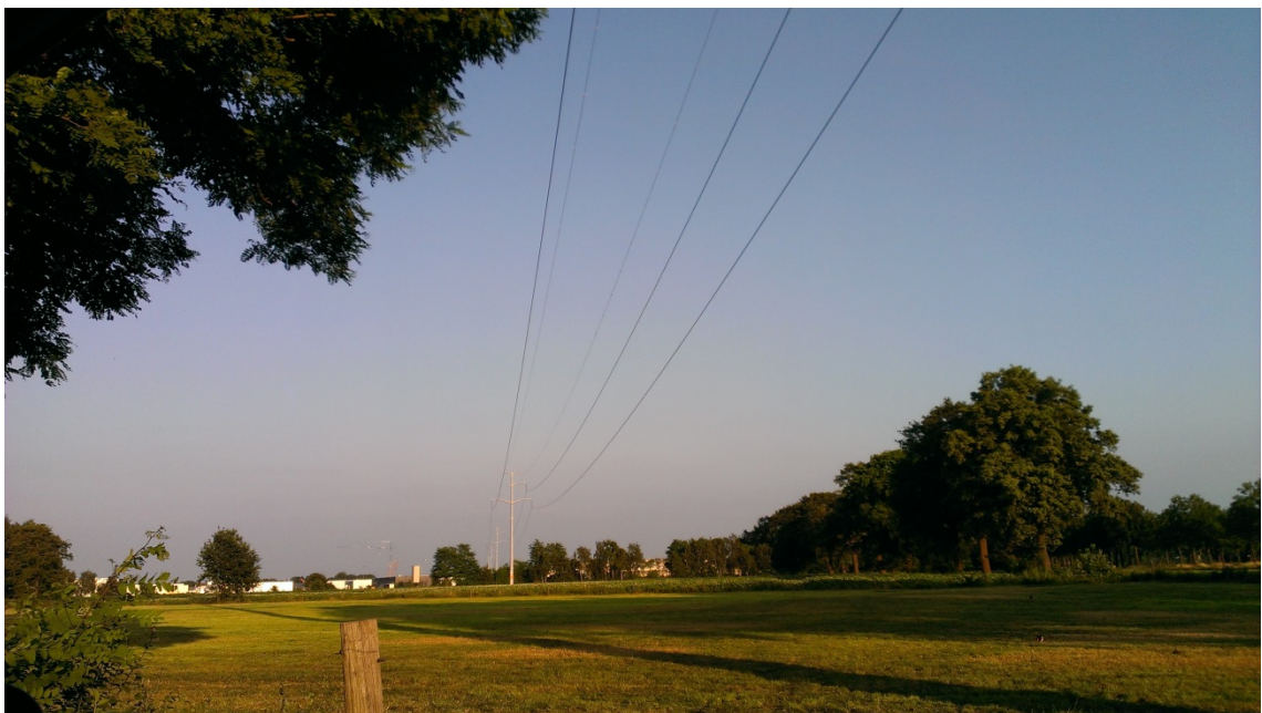
Figuur 5-2 Hoogspanningsmasten gefotografeerd vanaf de Ruitersweg (Foto: Ellen van Norren, 2013)
