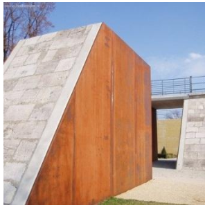
Abbeelding doorsnijding/beëindiging grondwal door middel van cortenstaal
