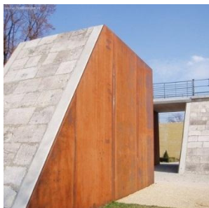
Abbeelding doorsnijding/beëindiging grondwal door middel van cortenstaal
