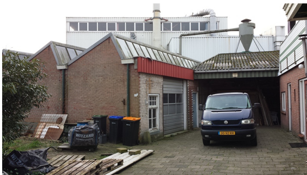
Foto 2 Noordgevel en houtmotinstallatie
