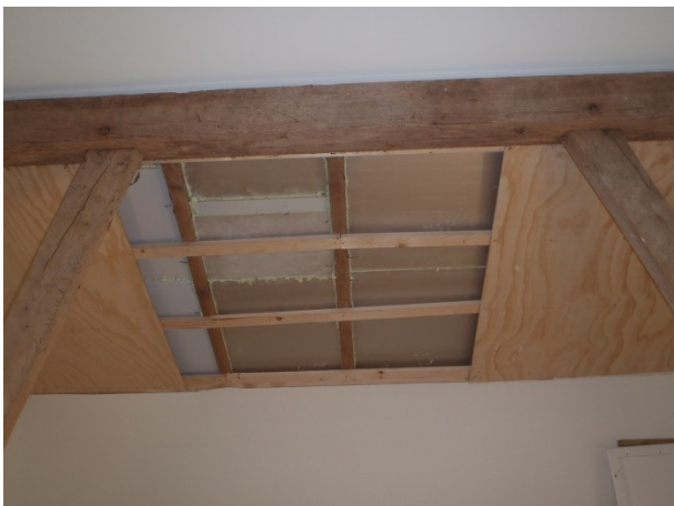
Foto 6: nieuw aangebrachte isolatie tussen de oude sporen van de woning.
