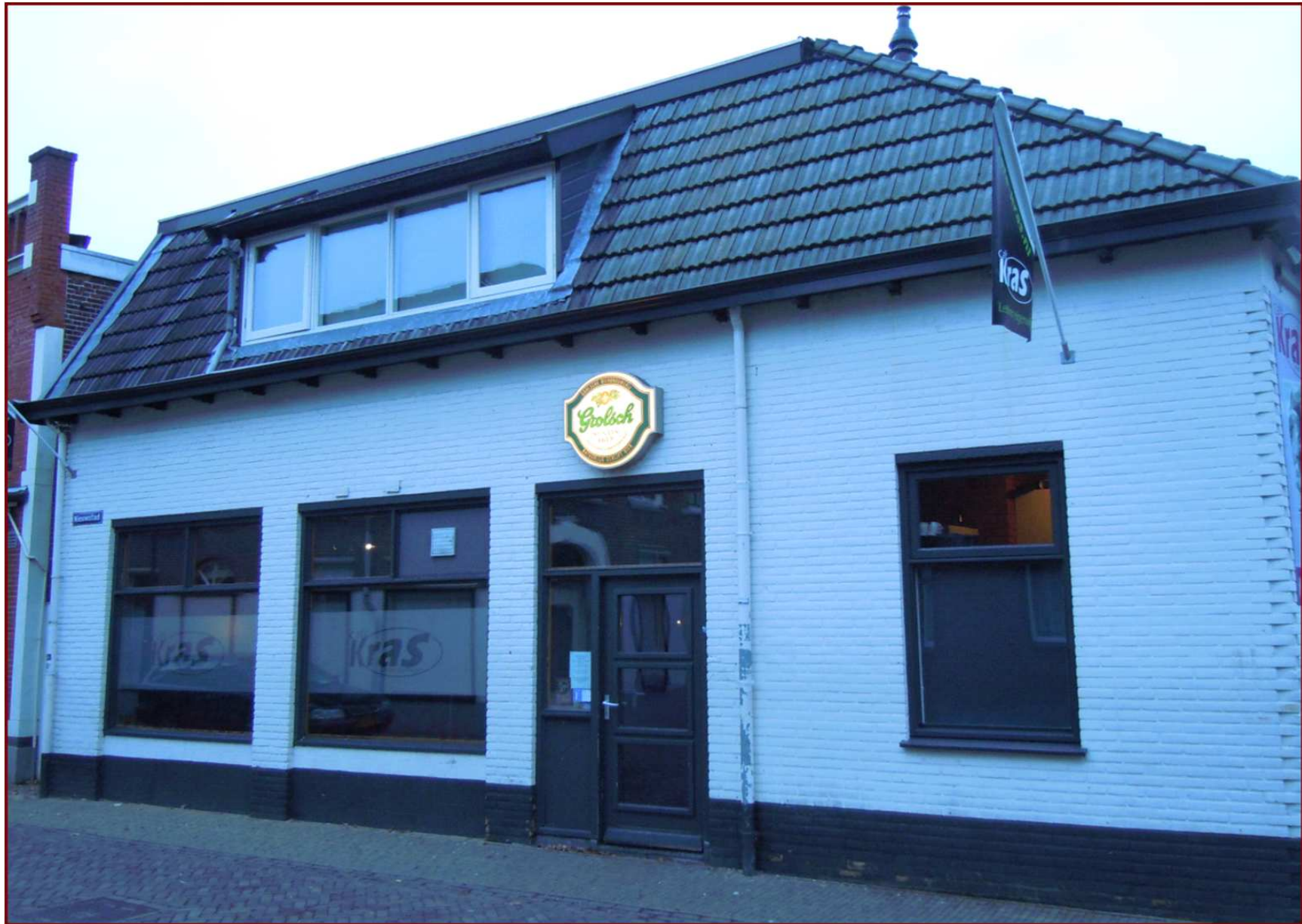
S.12.243.00 Nieuwstad 7 te Groenlo (Café Kras: westgevel)
