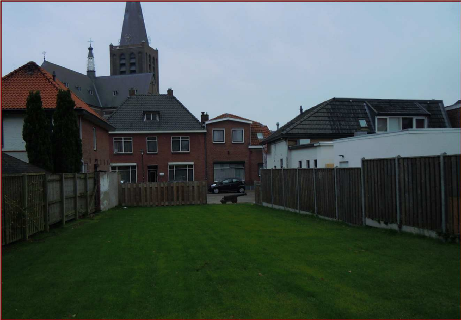
S.12.243.00 Nieuwstad 7 te Groenlo (Café Kras: zuidgevel)
