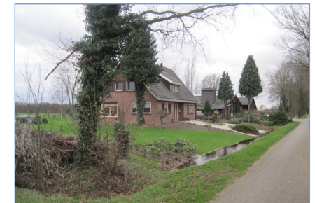
Erf aan de Voshuttedijk vanaf de oostzijde. Op de voorgrond het woonhuis.
