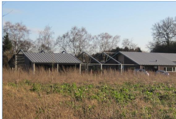
Transformatie van een schuur naar woning binnen de originele spanten en silhouet.
