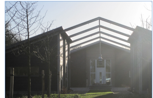
Transformatie van een schuur naar woning binnen de originele spanten en silhouet.
