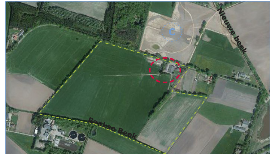
Luchtfoto circa 2010. De aanleg van het landgoed (C) is al deels zichtbaar. De groene lijn geeft de gronden aan die horen bij Voshuttedijk 4. Daar binnen bevinden zich waardevolle landschapselementen. De landschapselementen langs de Baakse Beek en de westelijke grens zijn van Staatsbosbeheer.
