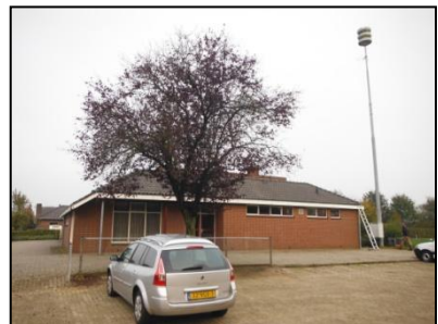
Figuur 5. Zuidelijk deel sportzaal.
