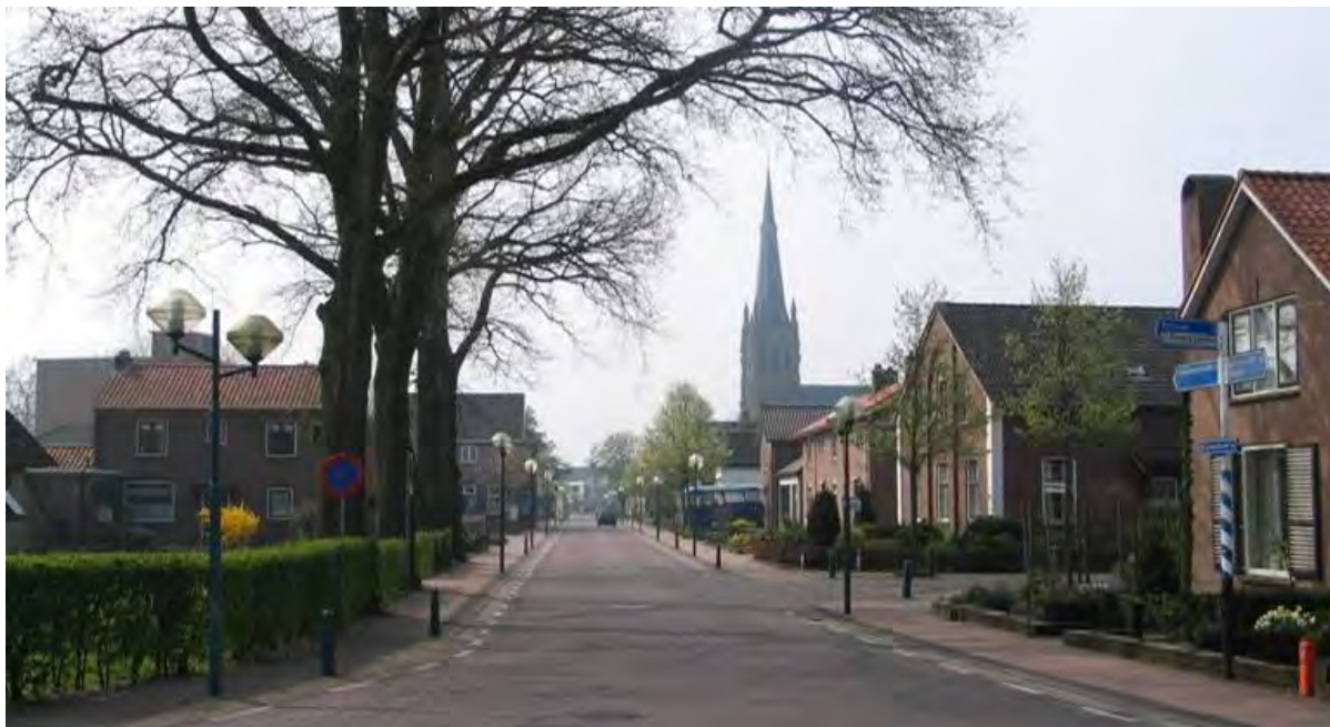
Dorpsstraat, ter hoogte van de Zegendijk
