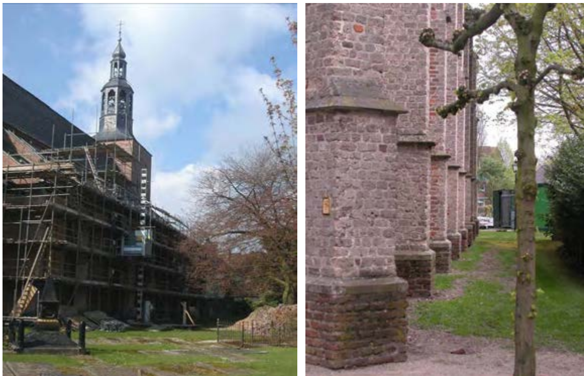
Links: restauratiewerkzaamheden Oude Calixtuskerk; rechts: steunberen van de zuidelijke gevel
