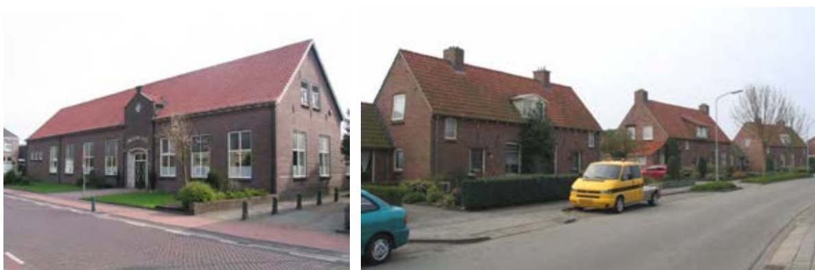
Links: R.K. parochiehuis; rechts: vroeg na-oorlogse sociale woningbouw aan de Harreveldseweg
