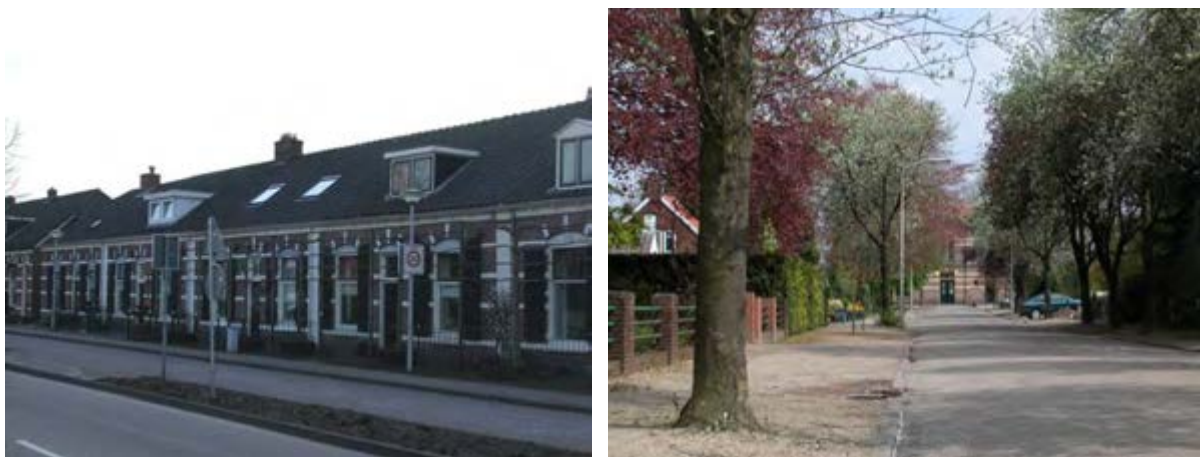
Links: tramarbeiderswoningen; rechts: Stationslaan met stationsgebouw op de achtergrond
