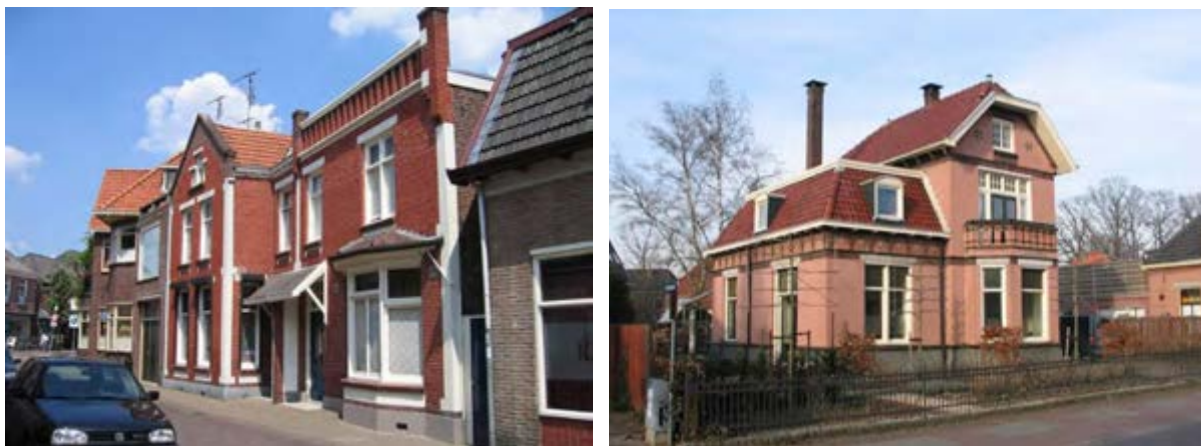
Groenlo, Nieuwstad 3 en 5 (links) en Dijkstraat 19 in Lichtenvoorde (rechts)
