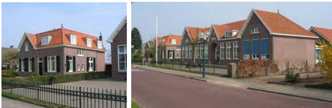
R.K. Canisiusschool en onderwijzerswoning
