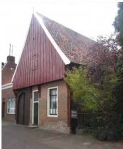
Museumboerderij Notenboomstraat 15, Groenlo: voorgevel met houten geveltop en rechter zijgevel met vakwerk
