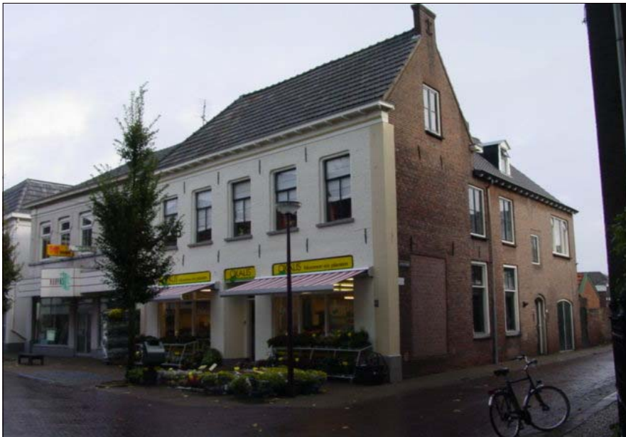
Recentelijk is de gevel van het pand aan de Beltrumsestraat 49 opgeknapt. Voorheen voldeed het pand niet aan alle criteria. Na een zorgvuldige gevelrenovatie voldoet het pand wel.
