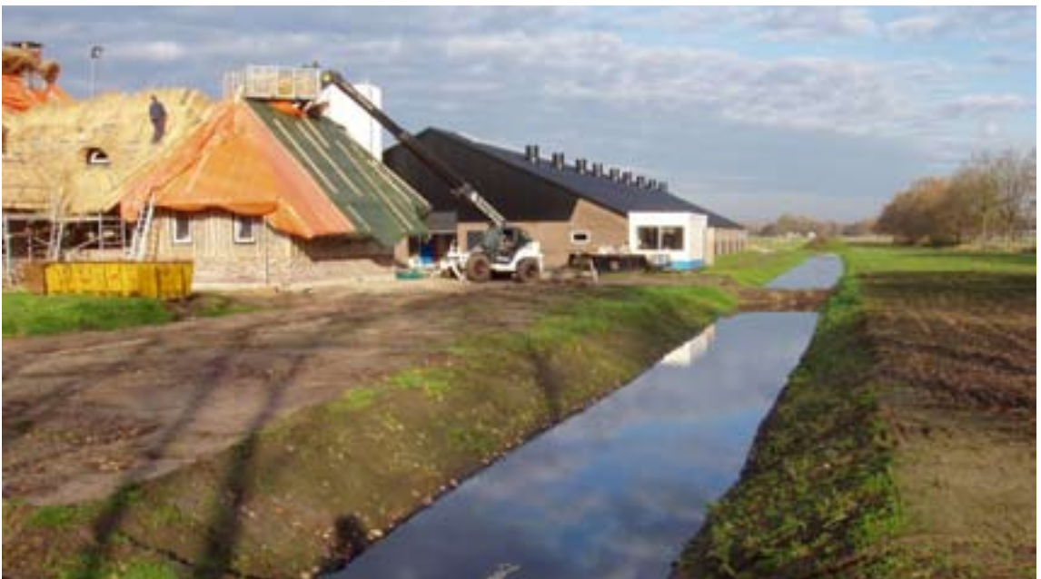
Nieuw intensief veehouderijbedrijf in aanbouw (verplaatser) in een ander LOG.
