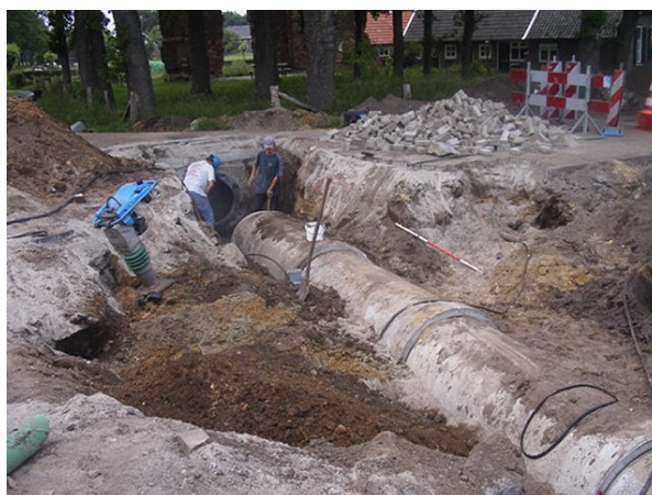
Vervanging riolering in uitvoering
