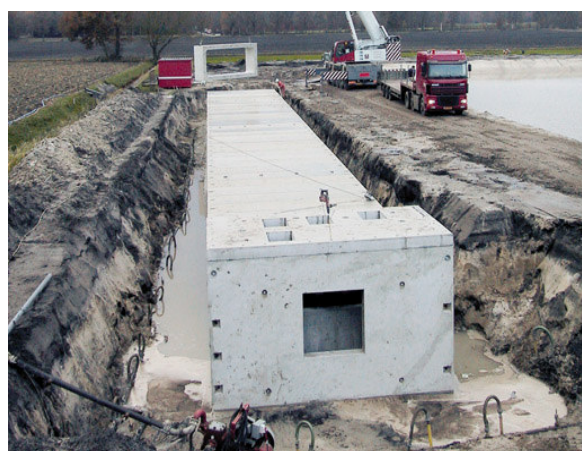
Bergbezinkbassin in aanbouw
