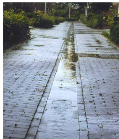
Bovengrondse afvoer van hemelwater
