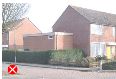
zijaanbouw te hoog
