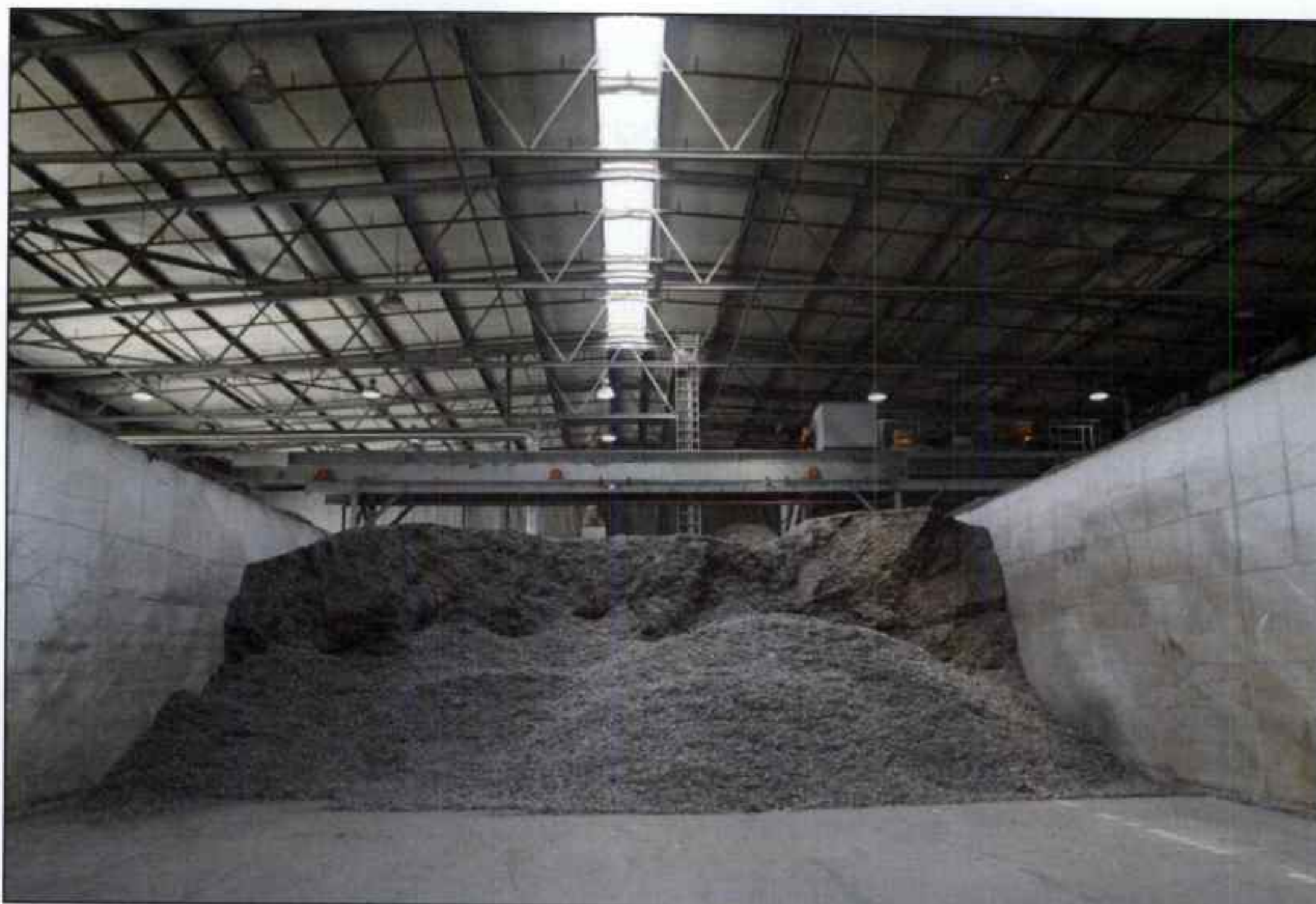
Afbeelding 3.2 Eindproduct Albra-installatie (hoogcalorisch materiaal Fluff)
