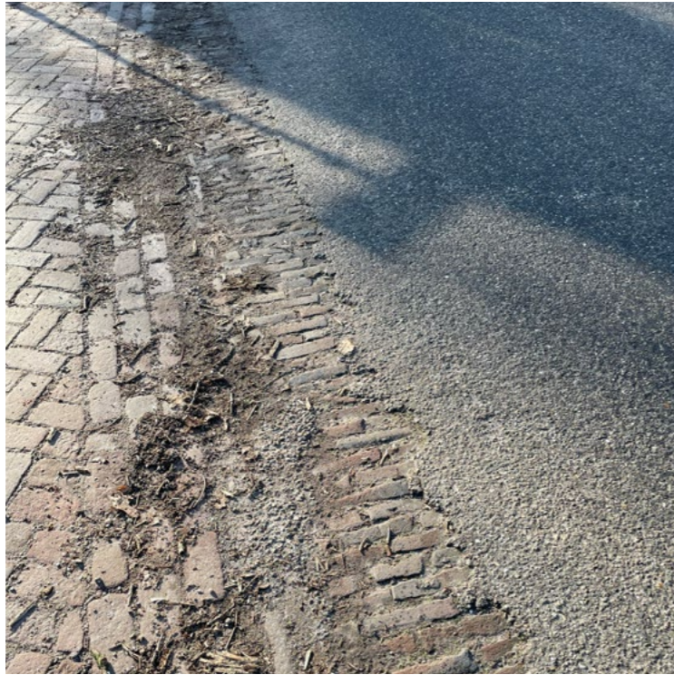
Oude gebakken klinker onder het asfalt. Hergebruik mogelijk?
