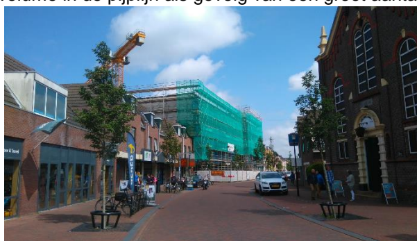
In aanbouw: 72 zorgappartementen Groningerstraat
