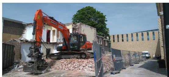
Binnenstad: sloop / nieuwbouw 5 appartementen KUUB
