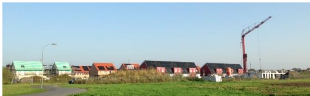
In aanbouw: "De Vosholen" Hoogezand-Sappemeer (foto Ramon Hoogeven gemeente HS)
