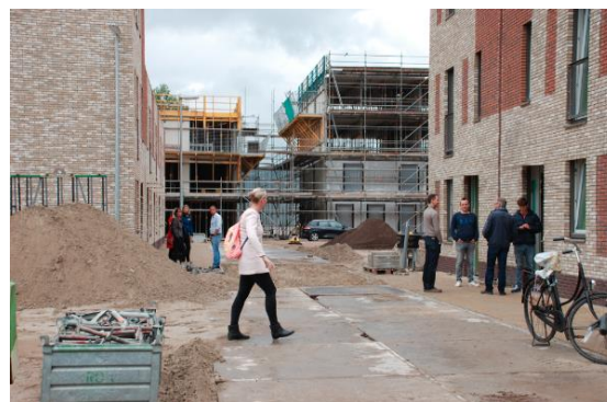
Oplevering nieuwbouw Groningen Eemskwartier
