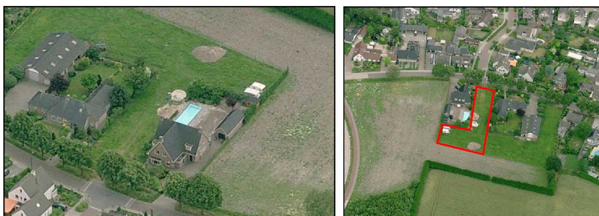
Luchtfoto's in vogelvluchtperspectief van het plangebied en de directe omgeving, gezien vanuit het noorden (linkerafbeelding) en zuiden (rechterafbeelding). Bron: Bing maps @2016
