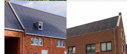
Zonne-panels geïntegreerd in dakvlak, vlakke dakvlakken
