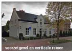
voorzetgevel en verticale ramen
