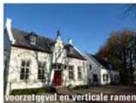
voorzetgevel en verticale ramen
