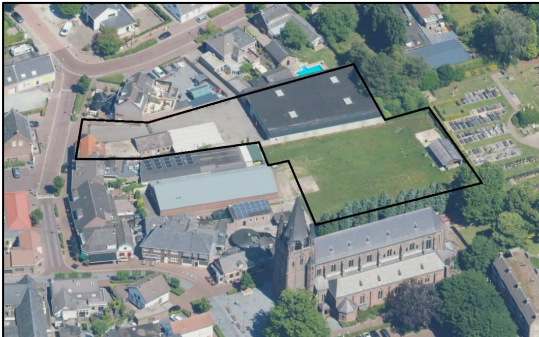
Afbeelding 1: Luchtfoto bestaande situatie
