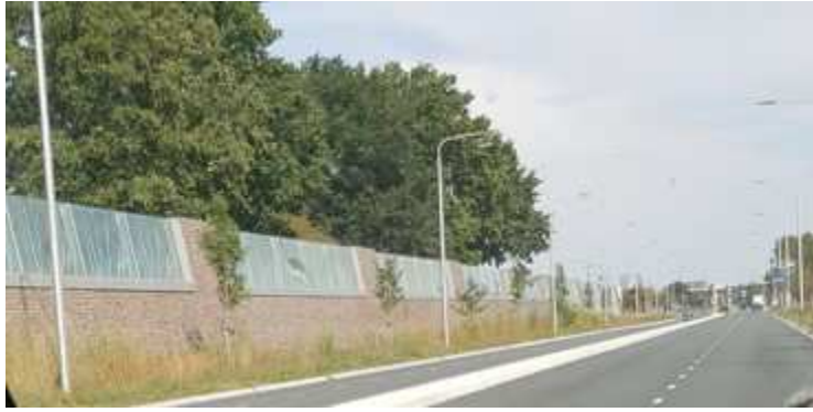
Afbeelding: bestaande geluidswal / -scherm langs de Kempenbaan
