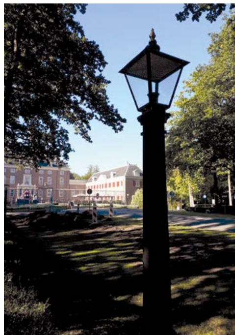
Een deel van de armaturen met natriumlampen is vervangen door LED.
