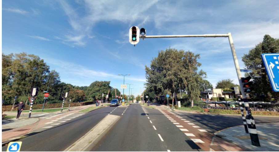
Figuur 8.2: Voorbeeld verkeerslicht (en middengeleider) bij overweg in Soest
