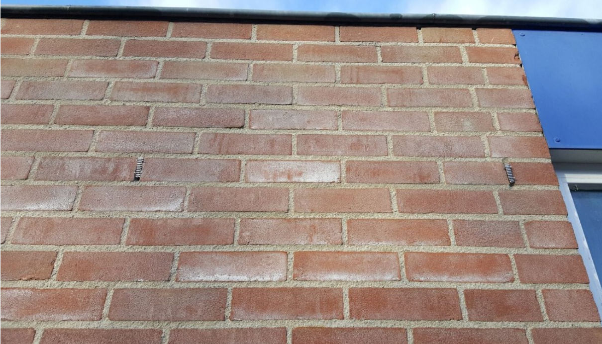
Afbeelding 5: Bijenbekjes versperren toegang tot potentiële verblijfplaatsen van vleermuizen. Foto: B. Verhoeven | Ecoresult B.V.
