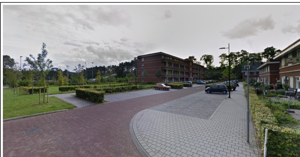
Figuur 8 – Projectgebied gezien vanaf de noordoostzijde (bron: Google Streetview)
