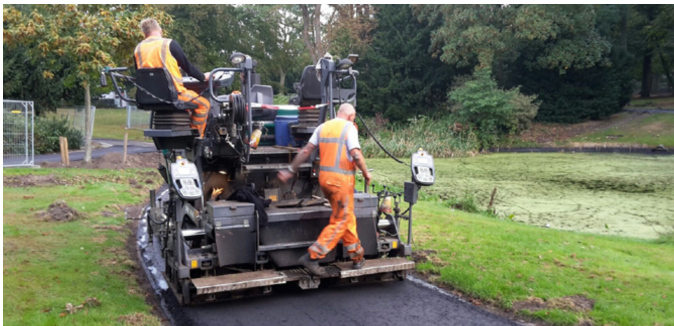
Asfalteren van de paden in het Walkartpark.
