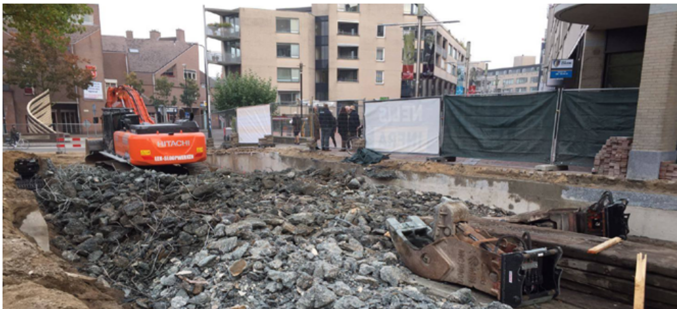
Sloop van de tunnel bij de Markt.
