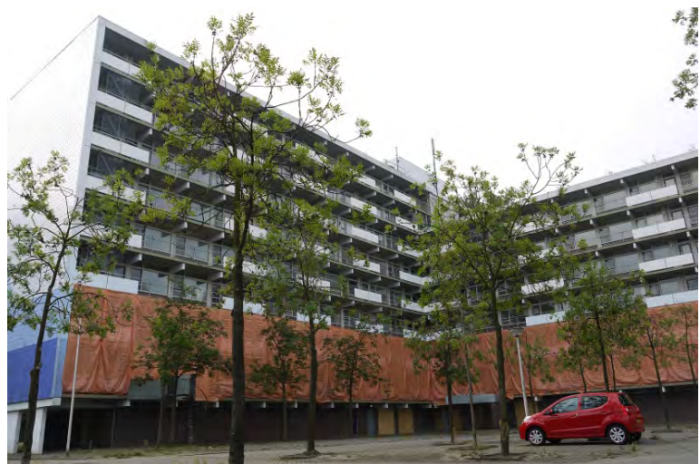
Met corporaties maken we prestatieafspraken over o.a. renovatie, zoals hier bij Flat 40 in Nijenheim.
