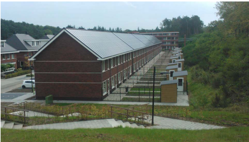
Energienota nulwoningen in de wijk Sterrenberg, Huis ter Heide. Door bij de bouw al direct te kiezen voor zonnepanelen, kunnen ze efficiënt geplaatst worden.
