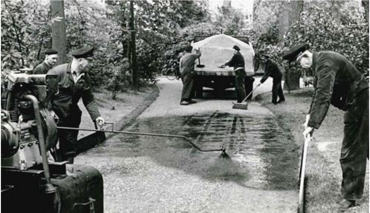
Figuur 6: Het asfalteren van de paden in 1965
