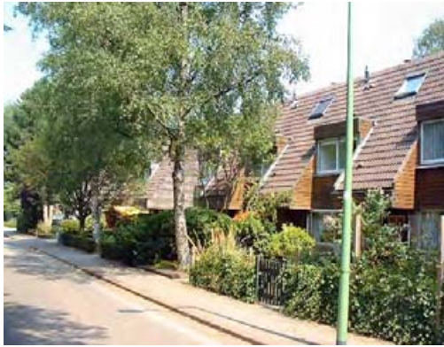
Naoorlogse woningbouw met veel groen aan de Hermelijnlaan.
