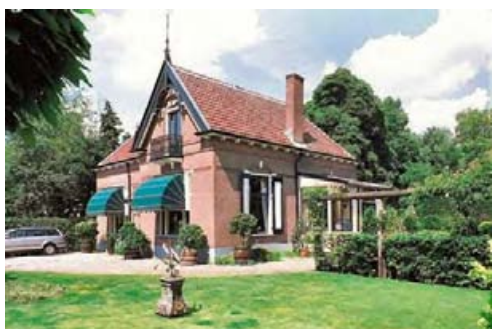
Villa aan de Driebergseweg.
