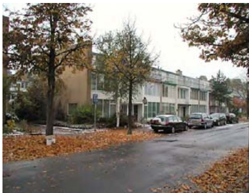
Functionele laagbouw aan de Montessorilaan.
