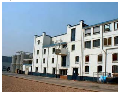
Historische bebouwing staat besloten op het terrein. Detailleringen zijn nog duidelijk te zien.
