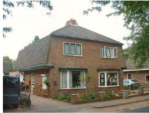
Typische vooroorlogse arbeiderswoning aan de Oude Postweg.
