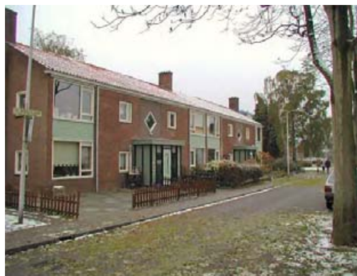
Vernieuwing van woningen aan o.a. de Dr. Wibautlaan.
