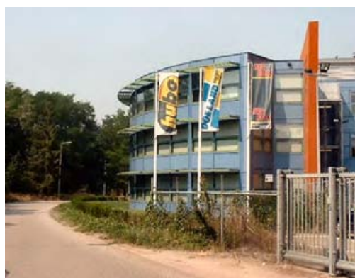
Representatieve bebouwing bij de entree van het bedrijventerrein aan de Fornheselaan.
