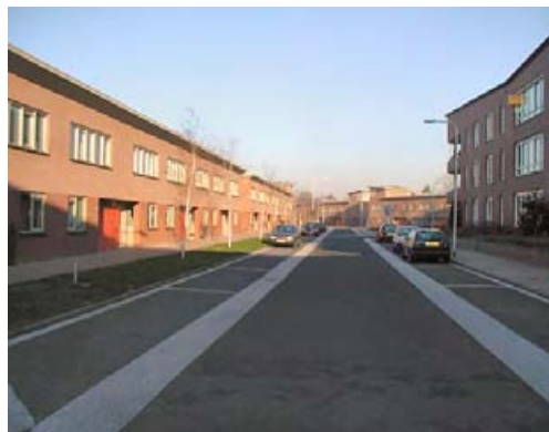
Recente nieuwbouwwoningen aan de Gandhilaan.
