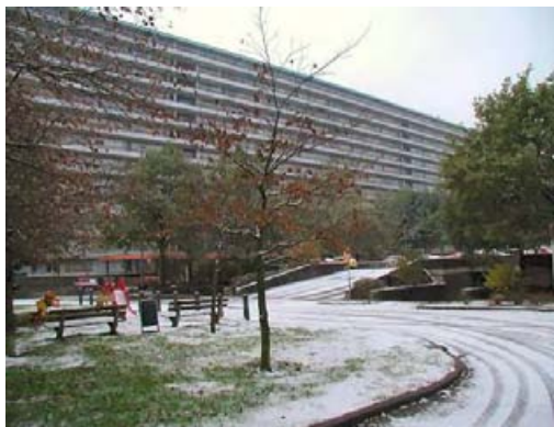
Grootschalige flatgebouwen aan de Laan van Vollenhove.
