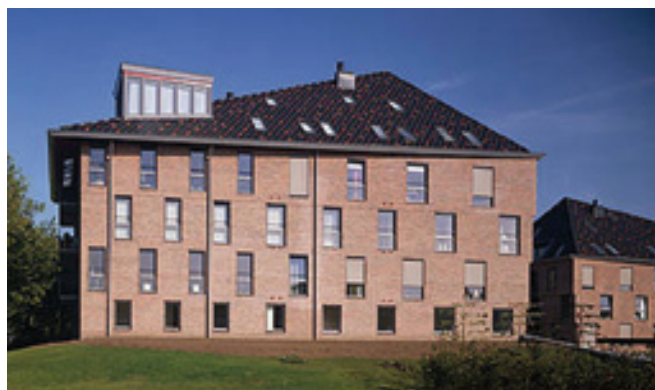
Voorbeelden van compacte bouw
