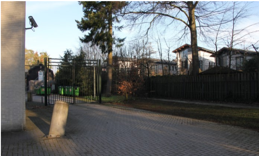
De binnenplaats is via de buitenkant toegankelijk via twee poorten naast het hoofdgebouw.
