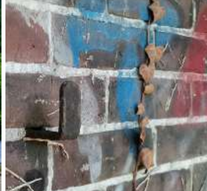
Afb. 3.23 Aan de noordzijde van de buurt ligt een verhard sportterrein. Dit wordt aan de noordzijde afgescheiden door de historische tuinmuur van Villa Nuova. De muur verkeert in matige conditie en slechte staat van onderhoud. In de muur zijn de haken voor de leifruitrekken nog steeds aanwezig.
