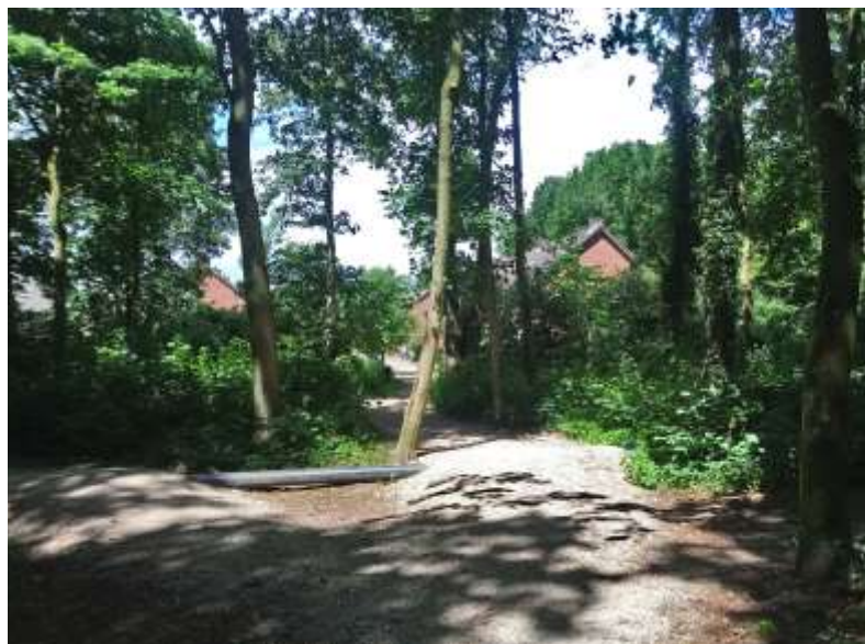
Afb. 3.17 De onafgewerkte paden, na grondwerkzaamheden in het noordelijk deel van het parkbos.
