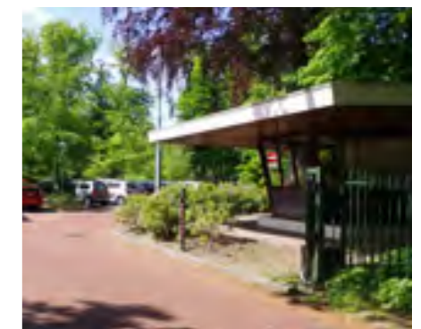
Bijzonder portiersgebouw TNO in zelfde stijl als het hoofdgebouw
