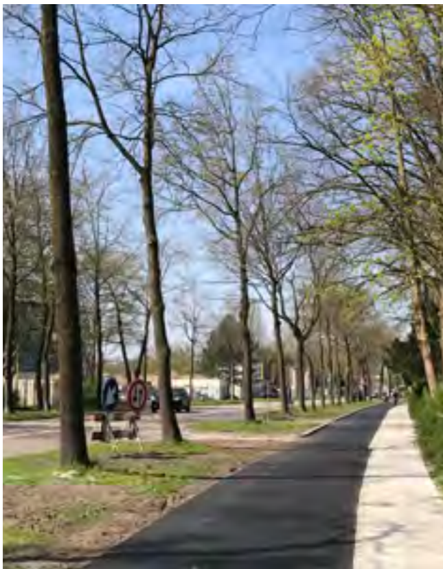
Noordzijde Utrechtseweg: fiets- en voetpaden worden niet onderbroken door inritten en / of ventwegen. Doorgaande fietsroute van donkergrijs asfalt en trottoirs bestaan uit betontegels: locatie van inrit parkeerterrein Eikenstein
